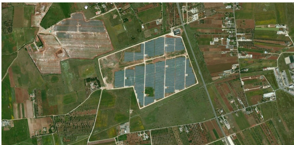
Impianto fotovoltaico installato a terra
