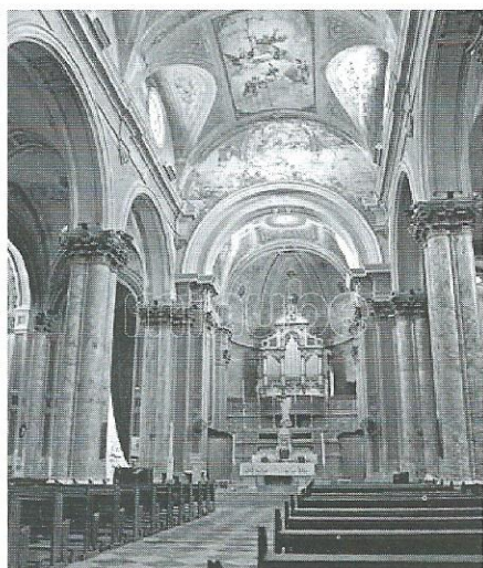
Navata centrale della Chiesa Madre in Galatina prima dei lavori di restauro.
